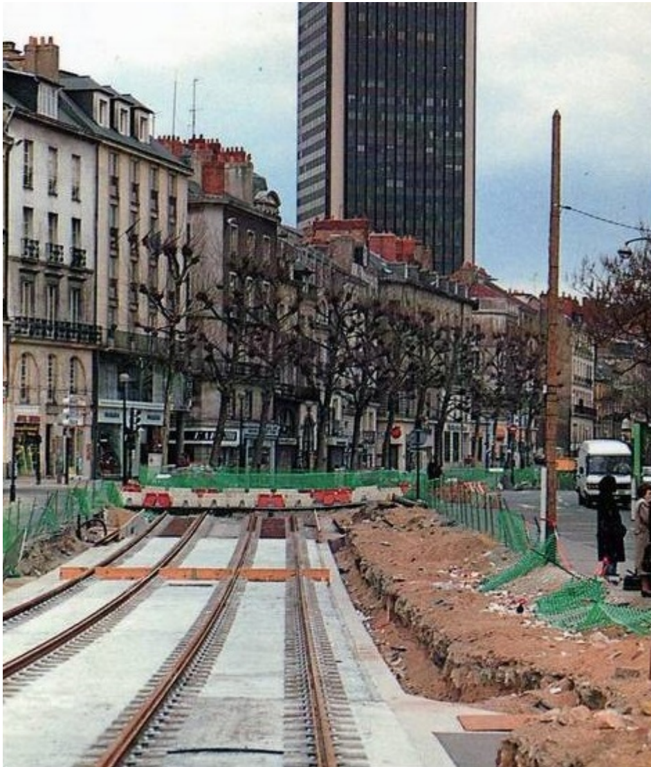
Photo : Travaux de la ligne de Tram sur le Cours des 50 Otages en 1992 vu depuis le Sud ( blog source )
